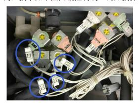
3.拆卸如下图所示 4 个固定螺丝, 并向外拔掉四根软接水管。
